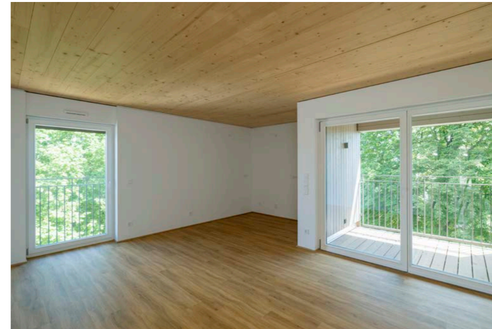
▲ Bei den Decken wird in GK 5 bezüglich Tragfähigkeit und Raumabschluss eine Feuerwiderstandsdauer von 90 Minuten gefordert
